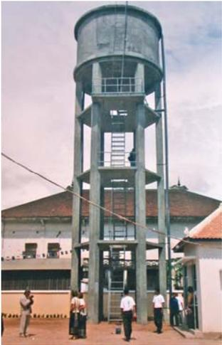
... viene spinta nel serbatoio pensile (18 m di altezza, 56 m<sup>3</sup> di capacità), da dove viene distribuita nelle case.
